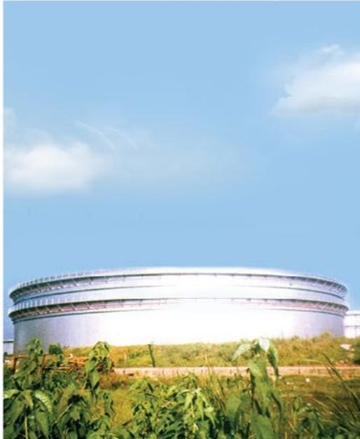
ساخت و نصب ۲ دستگاه مخزن ذخیره سقف شناور پالایشگاه بندر چیتاگونگ با ظرفیت هر کدام ۸۰۰۰ بشکه متر مکعب و نصب ۳ دستگاه مخزن ذخیره افقی ۱۰۰۰ متر مکعبی با تراز تقریبی ۱۳۵. تن در کشور بنگلادش از جمله پروژه های بیرون مرزی این شرکت می باشد که کلیه عملیات محوطه سازی، جاده سازی، تسطیح، شمع کوبی، احداث فونداسیون، پایپینگ، نصب مکانیکال، اطاق فرمان، میکسرها، ترانس ها، برق و ابزار دقیق، سندبلاست و رنگ آمیزی، کالیبراسیون و تست هیدرولاستاتیک مخازن با موفقیت به اتمام رسیده است.
